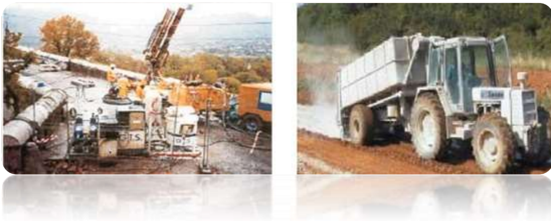
Fig. I.8: Traitement chimique à la chaux et au ciment.
